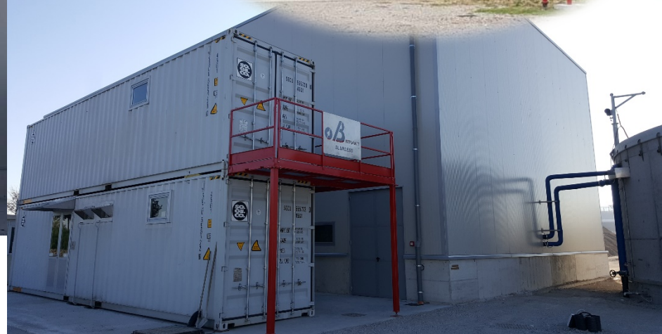
Unità containerizzata a 3 stadi di Osmosi inversa
